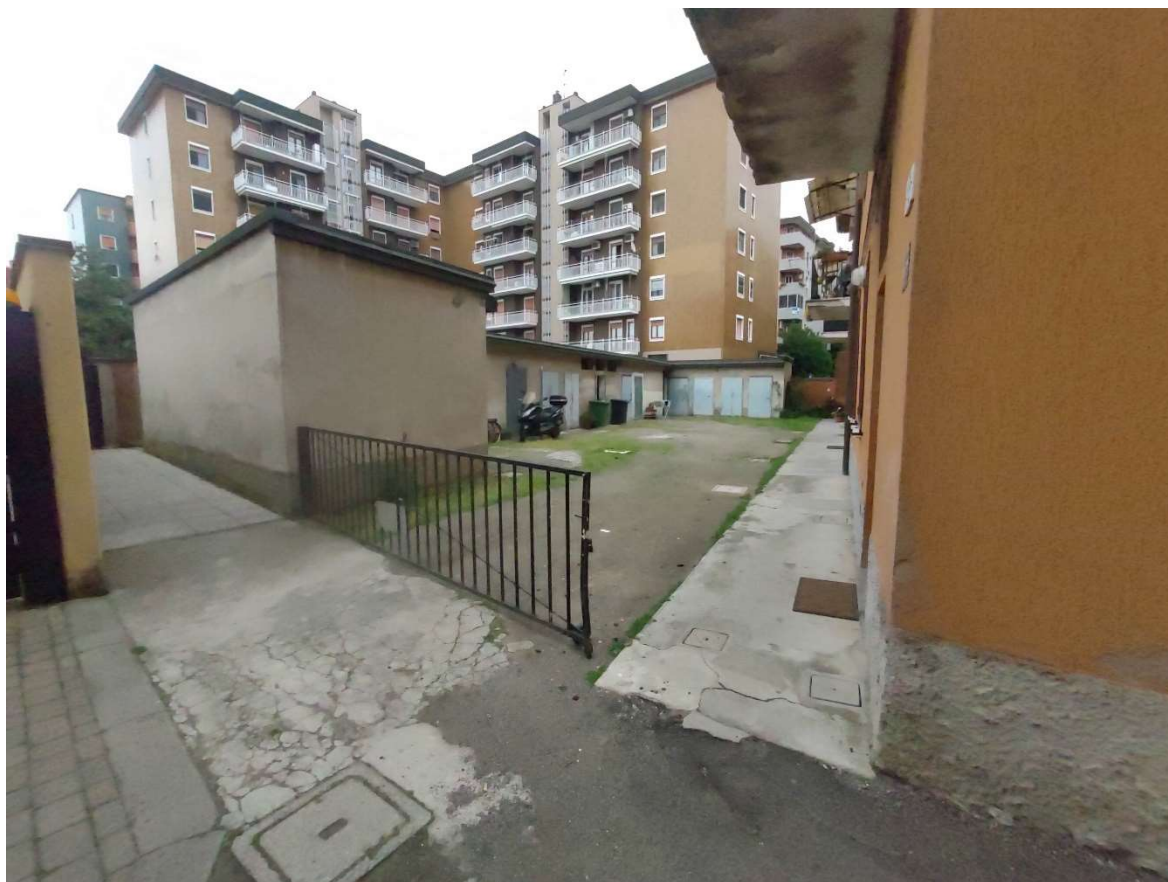
Foto n. 3 – Ingresso al fabbricato
