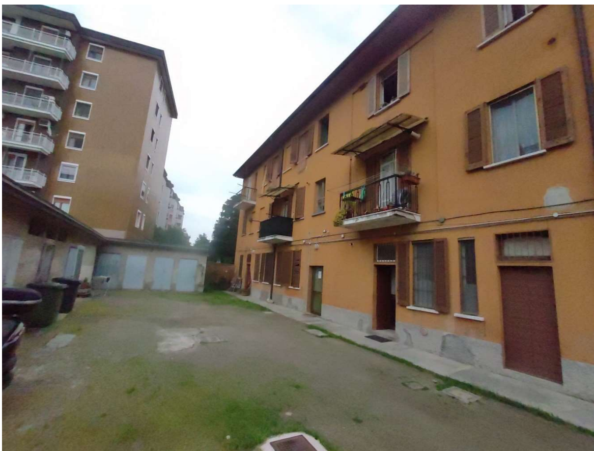
Foto n. 2 – Altro prospetto dell’edificio
